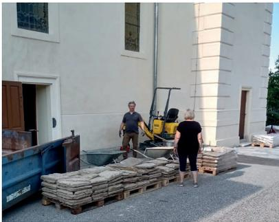
Am 30. Mai begann die Baumfirma mit den Baggerarbeiten. 90m<sup>3</sup> feuchtes Bauschutt- und Sandgemisch wurden aus der Kirche entfernt, um anschließend den Boden neu, stabil und trocken aufbauen zu können. Im Zuge der Grabungen wurden auch Fundamentreste der Vorgängerkirchen gefunden.
